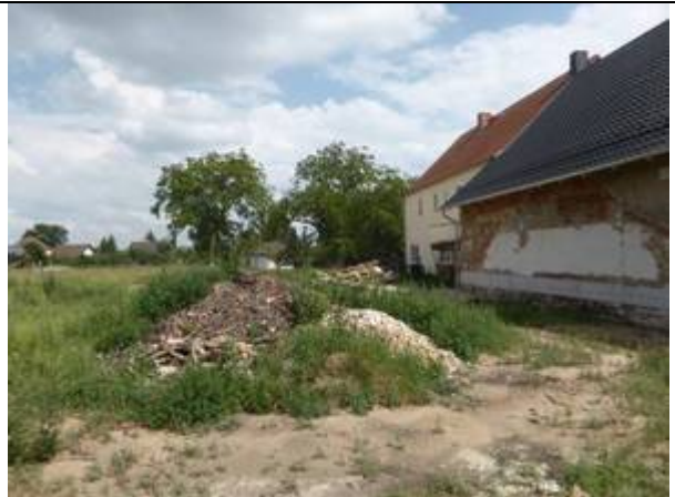
Foto 2: vorhandene Bebauung, Bauschutthaufen und zwei Walnußbäume (Foto: Wiesner, 21.6.19)
